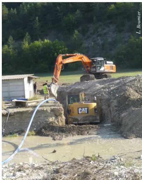
Sécurisation et enfouissement de la conduite d'eau potable
